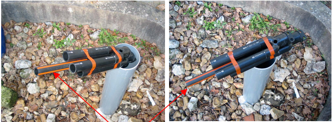
Tube d'injection du coulis
