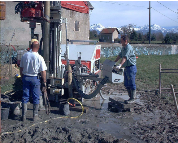
Illustration 7 - Chantier de forage au marteau fond de trou en cours de réalisation.
